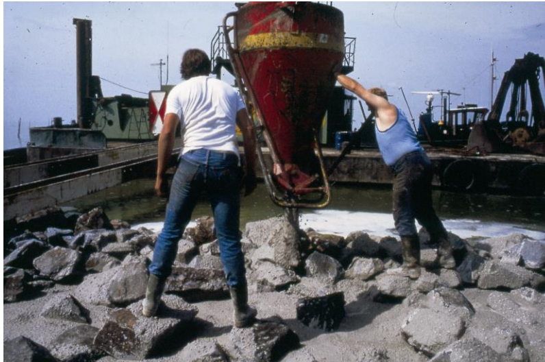
Figuur 3.6 Storten colloïdaal beton.
