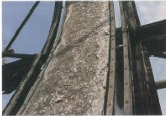
Figuur 3.2 Afgespatte toplaag.
