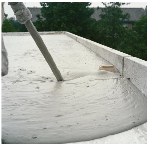
Figuur 3.3 Verwerken van schuimbeton.
